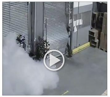
PROTECT sichert auch die Lagerräume von Elektronikgeschäften. Diese Aufnahme einer Videoüberwachung zeigt, wie es einem Einbrecher misslingt, sich Zugang zu einem durch Sicherheitsnebel geschützten Lagerhaus zu verschaffen.
